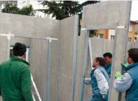
Resim 44 Prefabrik Bina İç Duvar Yapımı
