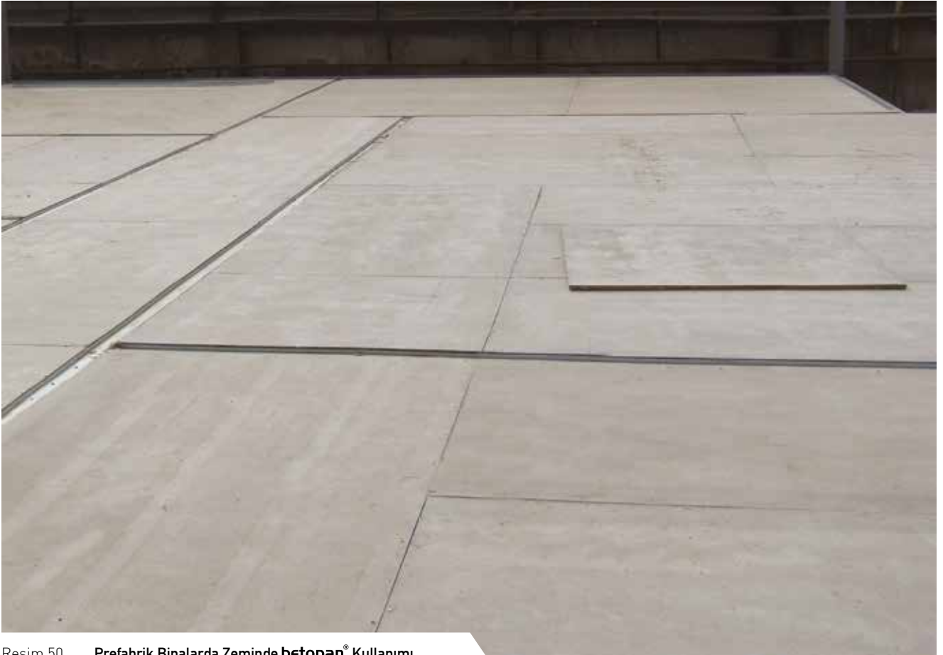
Resim 50 Prefabrik Binalarda Zeminde betopan ® Kullanımı
