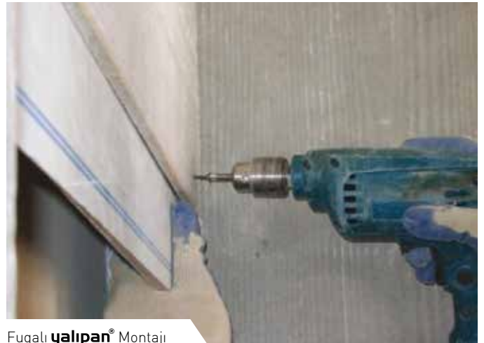
Fugalı yalıpan ® Montajı
