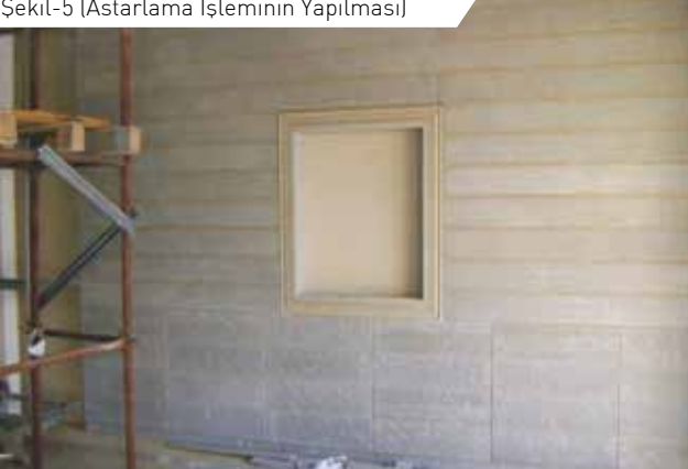
Şekil-5 (Astarlama İşleminin Yapılması)
