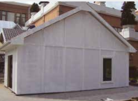
Resim 45 Astar boyalı Prefabrik Bina
