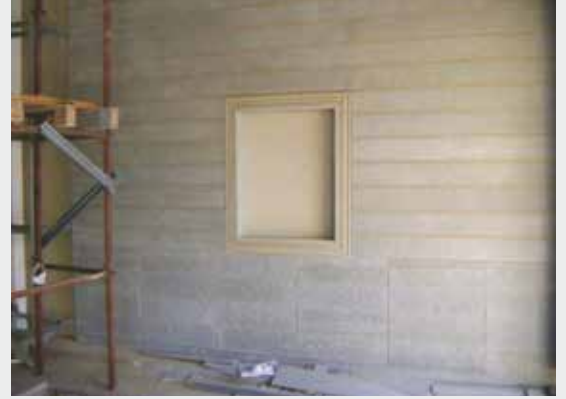
Montajı Bitmiş Yüzey
