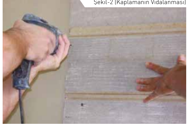
Şekil-2 (Kaplamanın Vidalanması)
