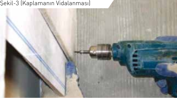
Şekil-3 (Kaplamanın Vidalanması)
