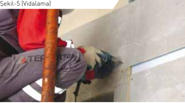
Şekil-5 (Vidalama)
