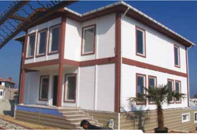
Resim 46 Boyası Bitmiş Prefabrik Konut
