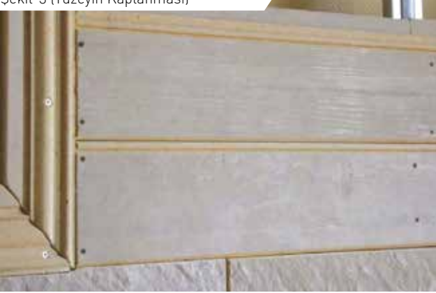
Şekil-5 (Astarlama İşleminin Yapılması)
