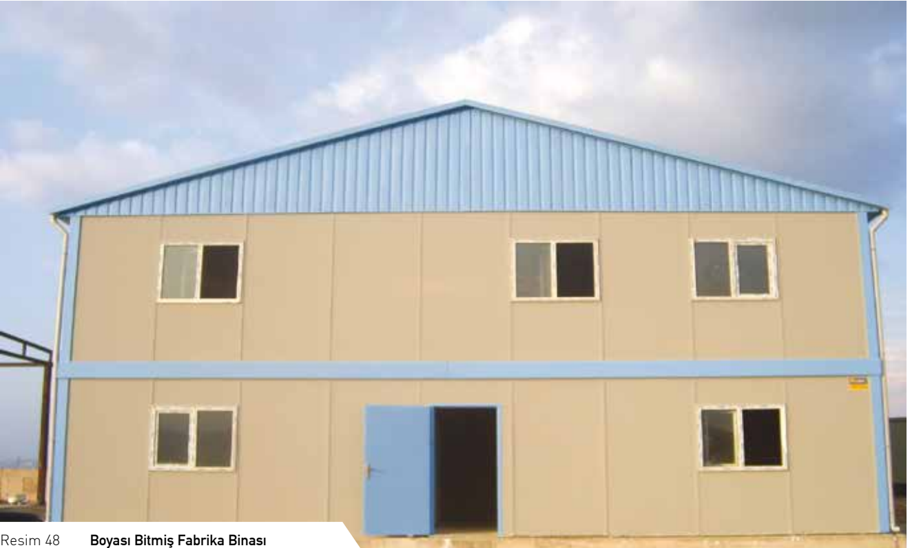
Resim 48 Boyası Bitmiş Fabrika Binası
