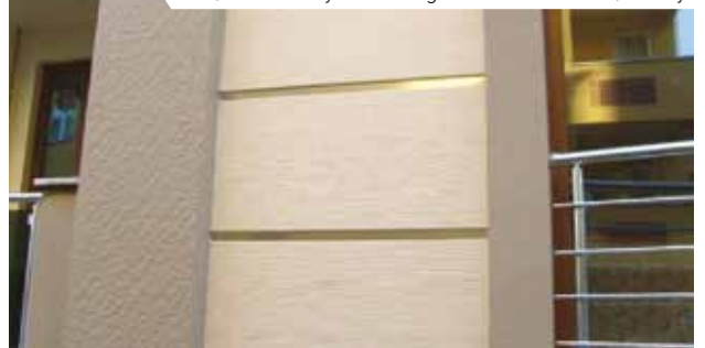
Şekil-8 (Boyası ve Fugası Tamamlanmış Yüzey)
